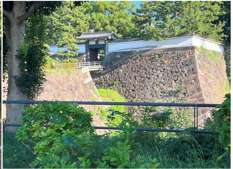
↑北桔橋(きたはねばし)門は跳ね上げ式で常に閉鎖 その下を玉川上水の樋が通り逆サイホンで水を上げた
