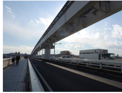
新井橋 右はモノレール
